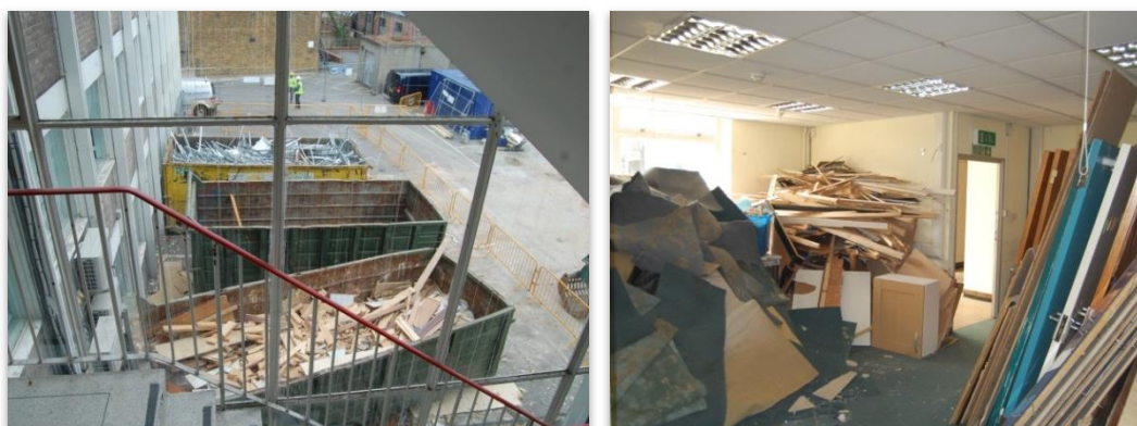
Separación en origen en una obra de demolición. Fuente: UEPG
