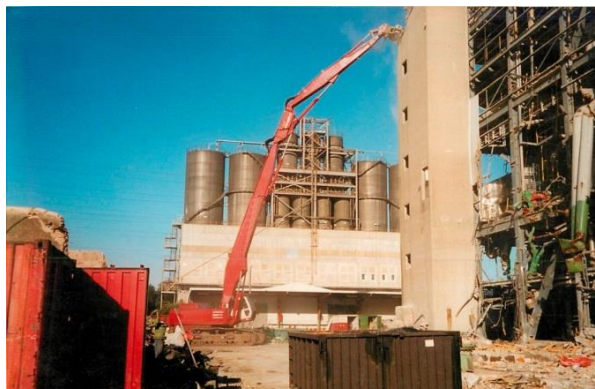
Lugar de demolición. Fuente: VERAS
