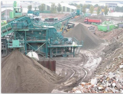
Centro de reciclaje de residuos de la construcción y demolición. Fuente: FIR
